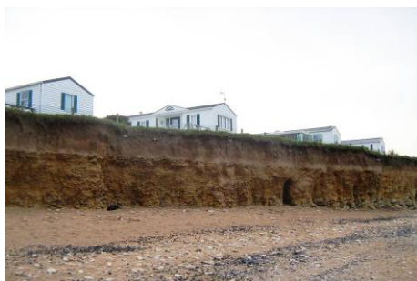
Figure 91 : Mobil homes implantés au bord des falaises de Lion-sur-mer, avec risque de chutes de bloc
