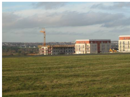
Figure 43 : Chantier de construction au sud de Fleury-sur-Orne
