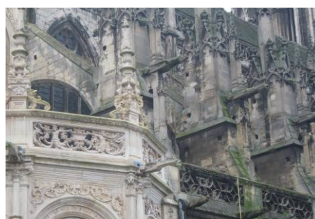
Figure 54 : Détail de l'Eglise Saint Pierre, montrant les effets de la pollution urbaine sur le patrimoine
