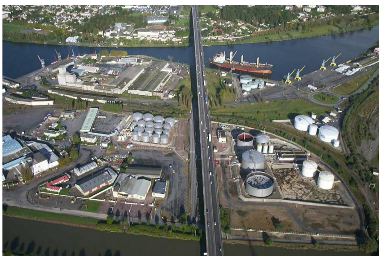
Figure 95 : LCN et DPC, deux établissements SEVESO à proximité immédiate du viaduc de Calix (le boulevard périphérique)
