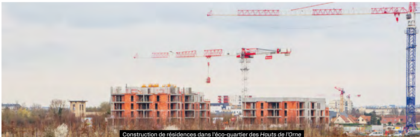
Construction de résidences dans l'éco-quartier des Hauts de l'Orne
